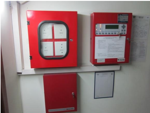
Pemeriksaan visual pada Main Control Fire Alarm
