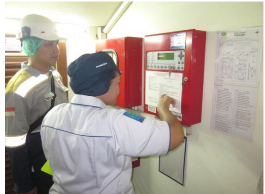
Pemeriksaan visual pada Main Control Fire Alarm
