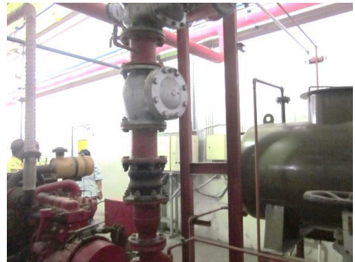
Pemeriksaan visual pada sistem instalasi pompa
