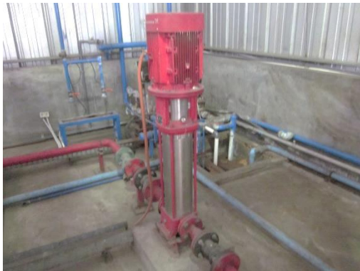
Pemeriksaan visual pada pompa pacu dan pompa cadangan
