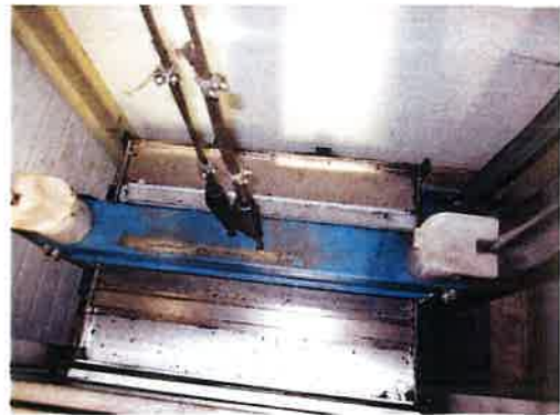
Pemeriksaan visual pada Lifting Point dan Car frame
