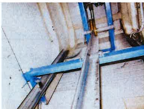
Pemeriksaan visual pada Hoistway Construction, Guide Rail dan Rail Bracket
