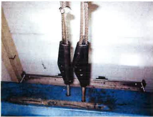
Pemeriksaan visual pada Lifting Point dan Car frame
