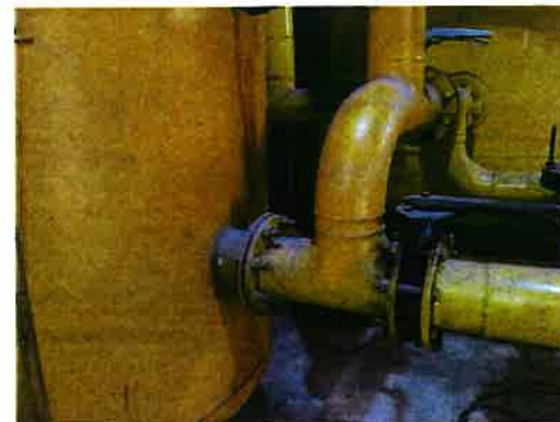
Pemeriksaan visual pada inlet dan outlet
