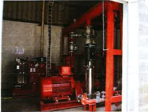
Pemeriksaan visual pada sistem instalasi pompa hydrant
