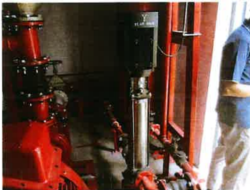
Pemeriksaan visual pada pompa pacu dan pompa utama
