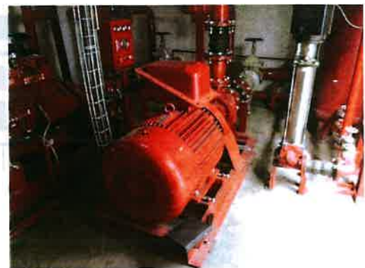
Pemeriksaan visual pada pompa pacu dan pompa utama
