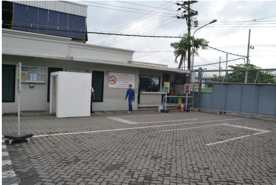
Gambar 3.23. Foto Kondisi Pos Security
